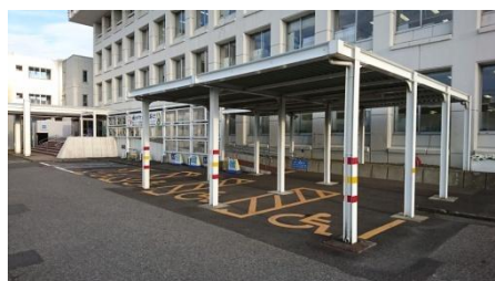
現庁舎前の状況： 身障者用駐車場と おもいやり駐車場
